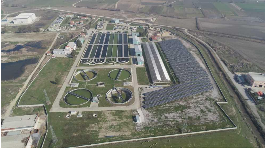
Resim 97 Manisa Maski Ges1 990 KW Güneş Enerji Santrali
