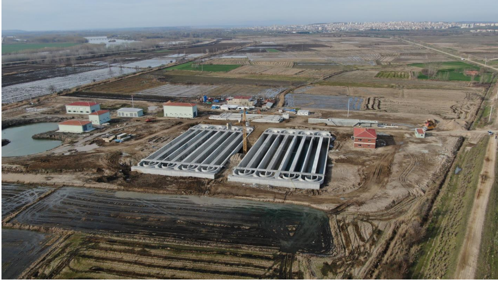
Resim 30 Edirne Merkez Atıksu Arıtma Tesisi
