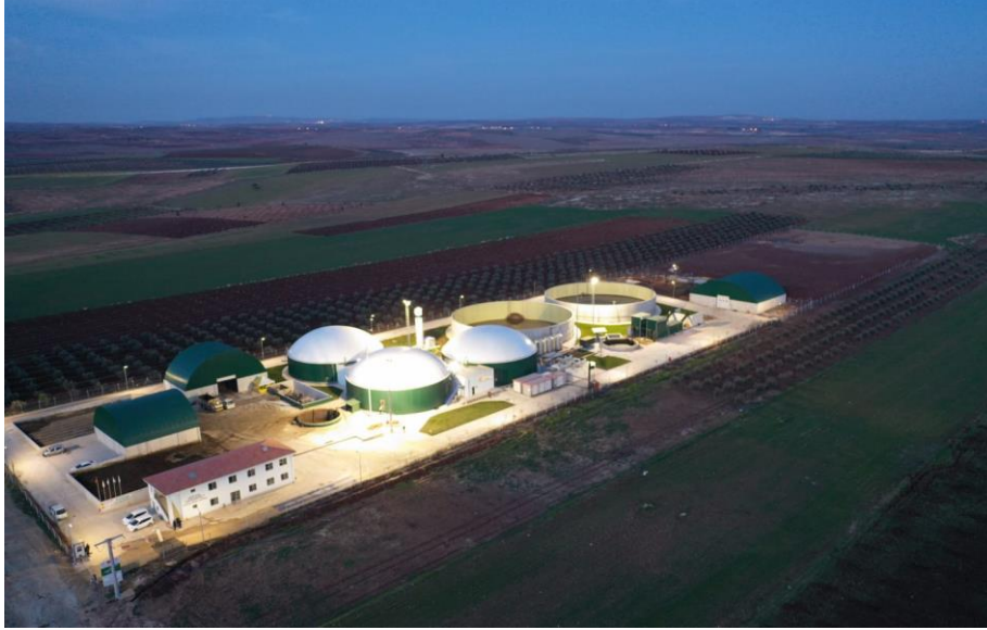
Resim 39 Oğuzeli Merkezi Biyogaz Santrali
